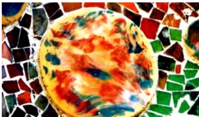
CERÀMICA I VIDRE DE LA FAÇANA DE LA CASA BATLLÓ
